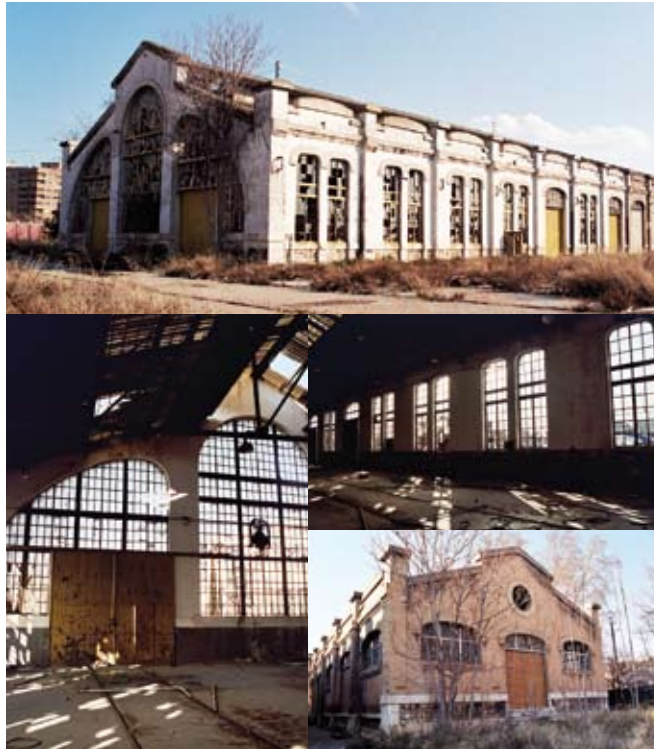
Interior y exterior de varias de las Naves de Ribes.
